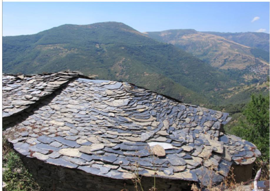
Le type de voûte traditionnel dans les Pyrénées est la voûte en encorbellement de schiste, qui reprend le dessin d'une chaînette. En effet, la voûte est le type de couverture qui répond le mieux à la charge de la masse rocheuse. Les toitures sont toujours relativement plates pour éviter le glissement des pierres vers le bas.
